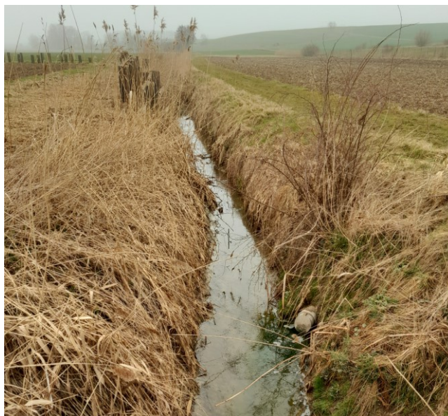
Figure 3 : Le Heylenbach à hauteur de la station de lagunage – vue vers l'amont (source : SDEA)
