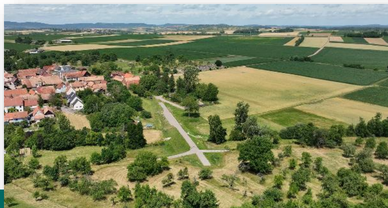
Exemple de travaux réalisés à Melsheim (67) par le SDEA
